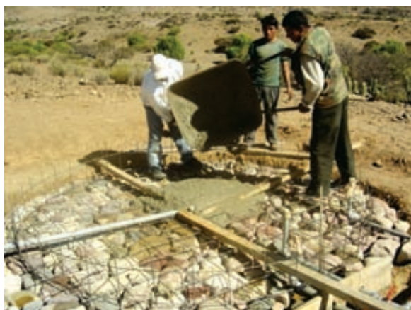
Foto1.1 Vaciado de losa de fondo
