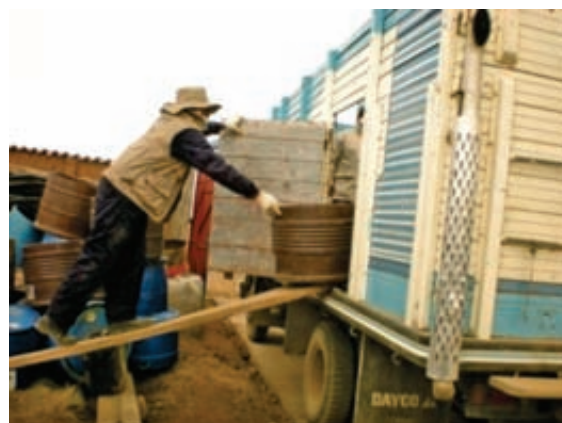
Fig. 1.2 Colocación en el camión
