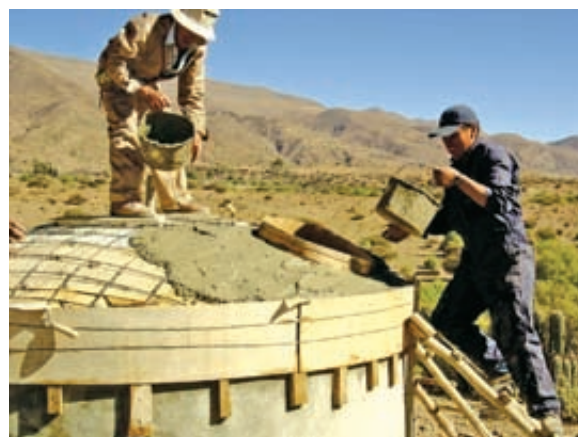
Foto 1.6. Vaciado de tapa
