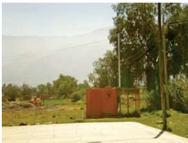
Foto 2. Torre Hidroneumática Clásica zona de Challacaba – C. Cochabamba
