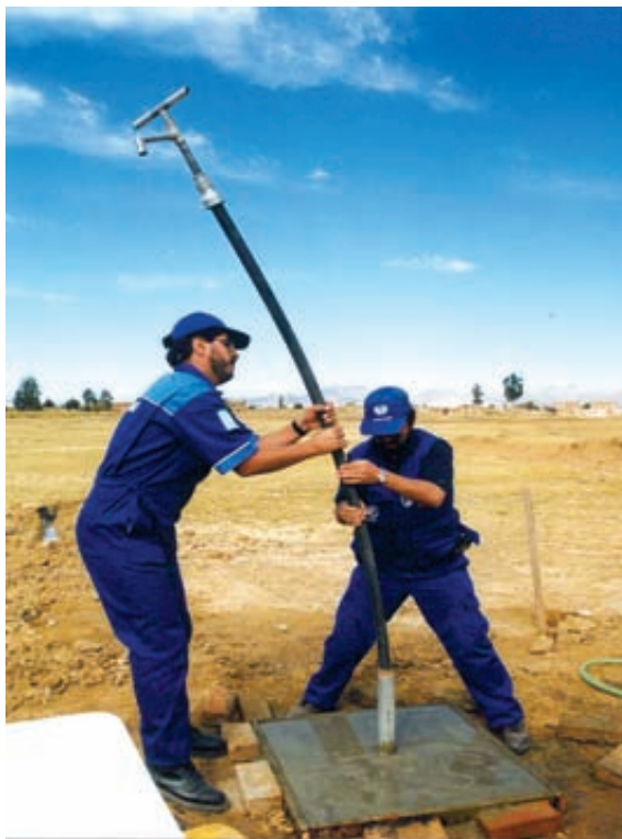
Foto 1.1 Colocación de la bomba
