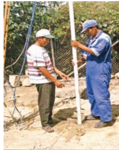
Foto 1.4. Encamizado del pozo
