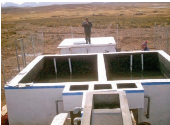
Foto 3. 5. Filtro grueso dinámico y FLA, Loc. Masaya
