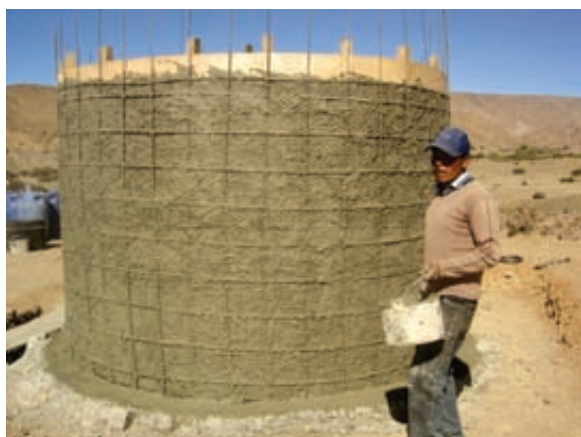
Foto 1.5. Revoque exterior
