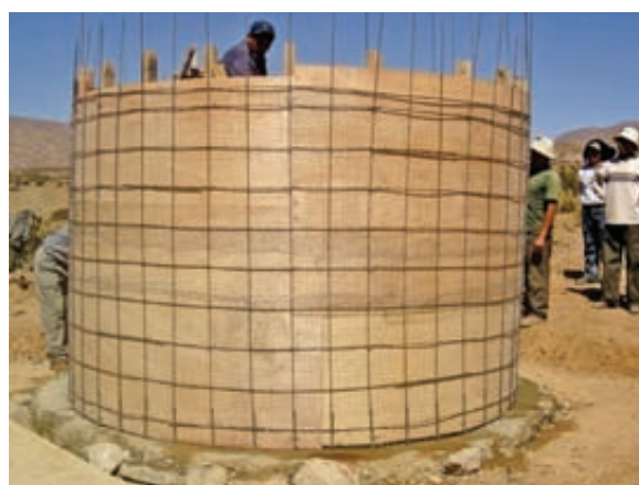
Foto 1.4. Encofrado interior
