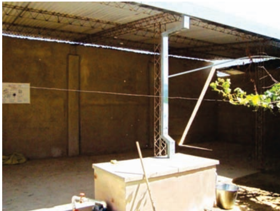
Foto 1.1 Bajante e interceptor Localidad: Ciudad de Cochabamba
