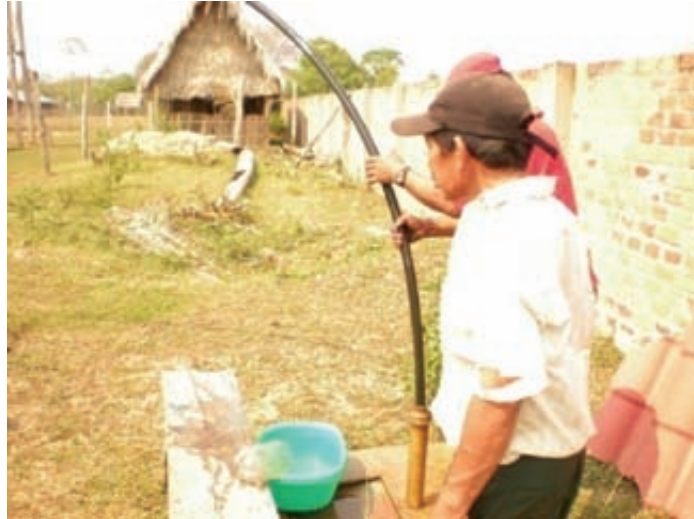
Foto1.6 Pozo perforado manualmente, Localidad Gualaguagua – Municipio Reyes
