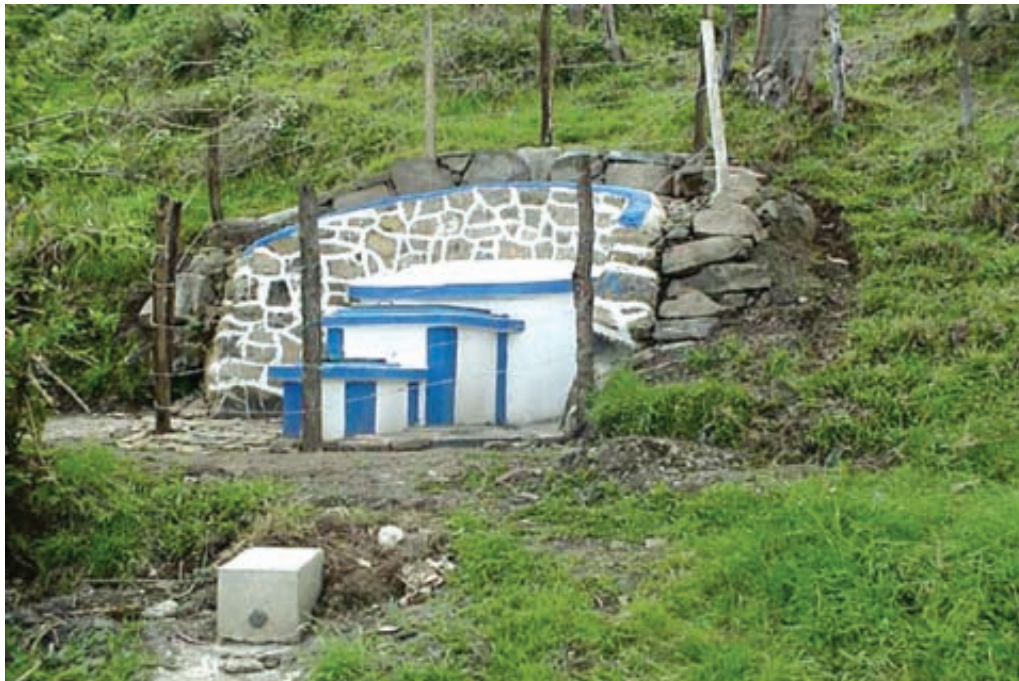
Foto1.1 Captación de ladera y primer cerco
