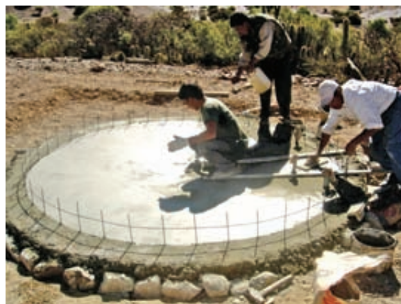
Foto 1.2 Concluida la losa de fondo
