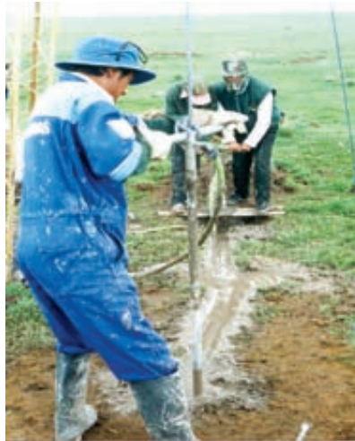
Foto 1.3 Proceso de perforación
