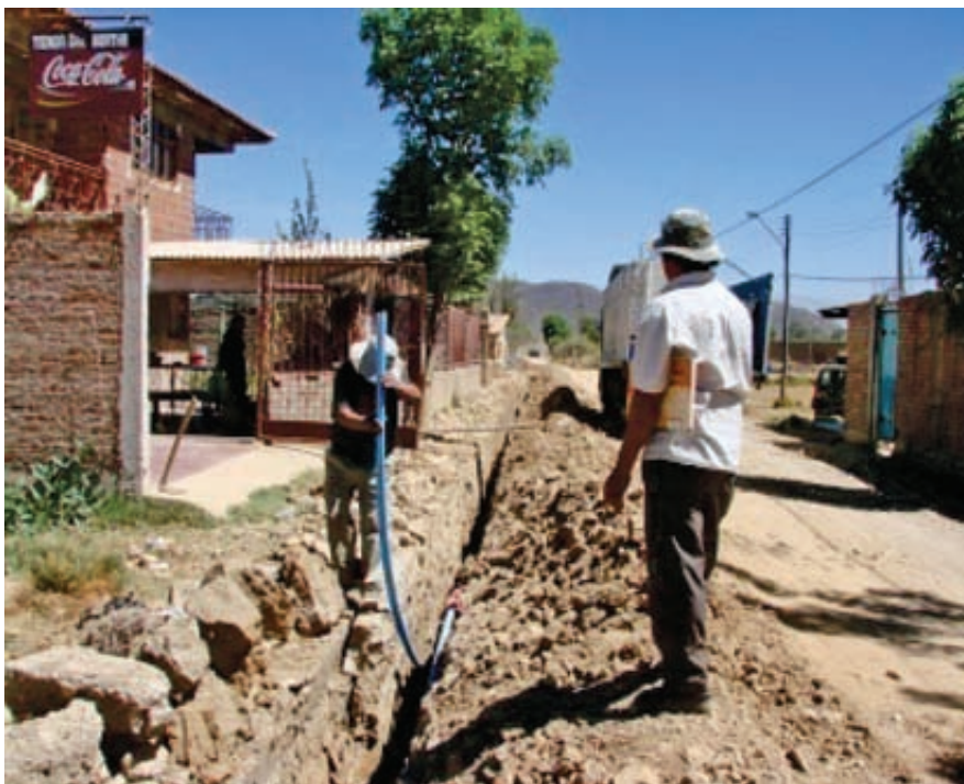
Foto 2.4 Tendido de tubería la Maica - C. Cochabamba
