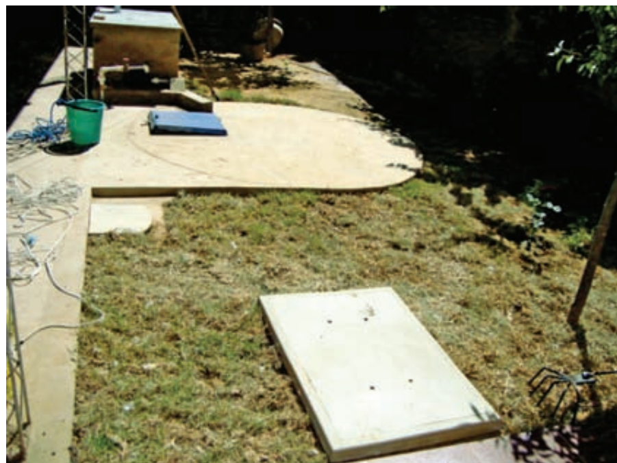
Foto 1.2 Tanque enterrado Localidad: Ciudad de Cochabamba
