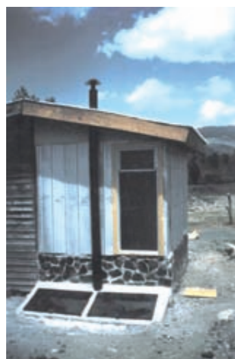
Fig. 2.10 Baño con panel solar domiciliario
