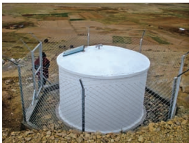
Foto1.8. Acabado con cerco perimetral
